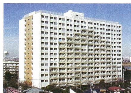
写真3 高層建築の耐震補強
