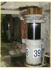
800トンジャッキ44台 がビルの柱を支えて 伸縮。
