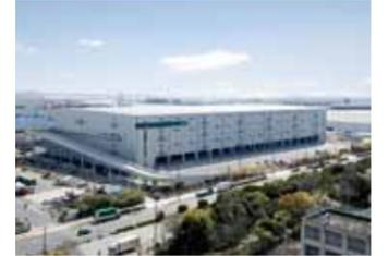
建設コストが安い中間層を支持層にする設計案①と、建設コストは高いが安心な基盤を支持層にする設計案②の2つが検討されました。調査の結果、中間層を杭の支持層として良いことがわかりました。これに基づいた設計施工を行うことで大幅な工期短縮とコスト削減を実現できました。
