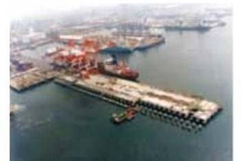
工事現場は河口付近にあったため、基礎杭の支持層である砂礫層が複雑な構造をしていました。調査結果とN値の比較から支持層の構造を正確に把握でき、効率的な設計と施工を行うことができました。調査結果と杭の施工記録が良く一致しており、調査結果が正しかったことがわかります。
